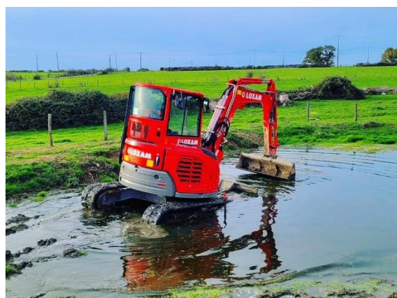
Photo 1- Chantier école © La MFR de Anse
