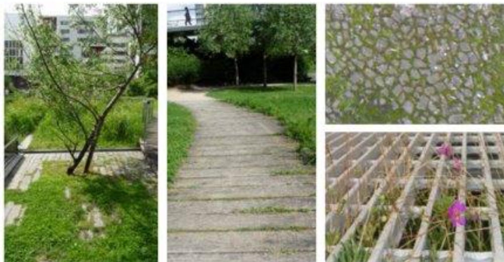
Exemple de revêtements perméables favorables à l'installation de végétations (photos prises à Paris) © Botape.
